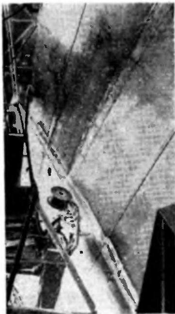
Рис. 131. Автоматическая сварка корпуса траулера порошковой проволокой с принудительным формированием.
