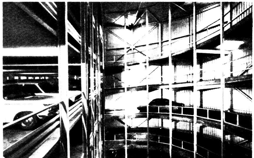
Внутренний вид башни въезда
