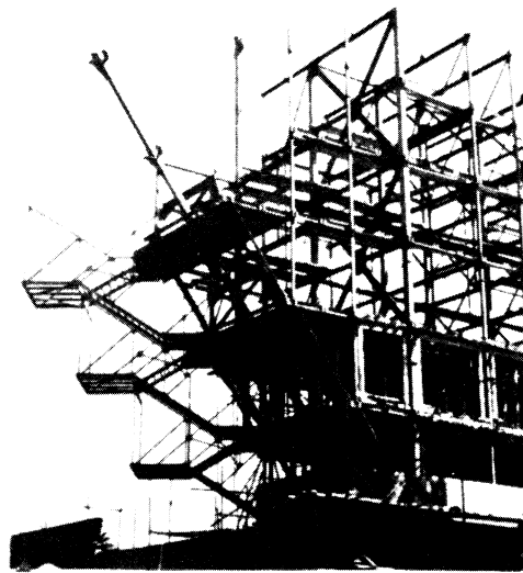
Стальная несущая конструкция торцовой стороны с наклонными стойками и горизонтальными анкерными листовыми дисками в процессе монтажа. Примыкание ветровых связей к поперечным балкам, напрягаемая арматура перед бетонированием ребристого перекрытия
