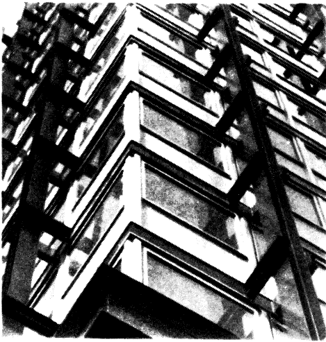
Фрагмент наружной стены
