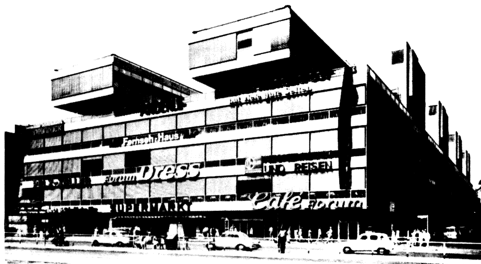
Торцовая сторона здания с главным входом
