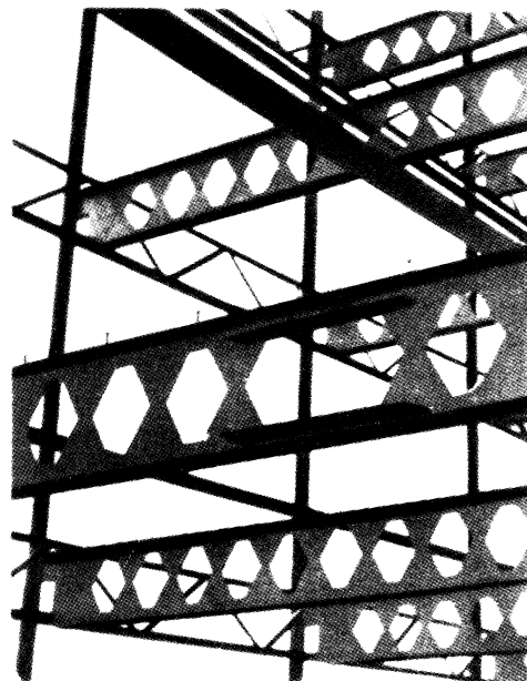
Примыкание балок перекрытия к подвескам
