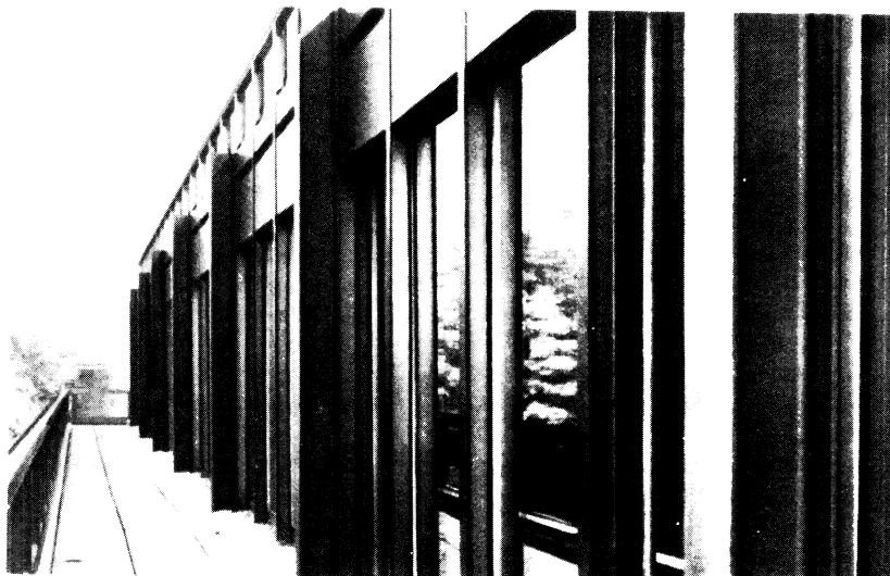
Фрагмент наружной стены
