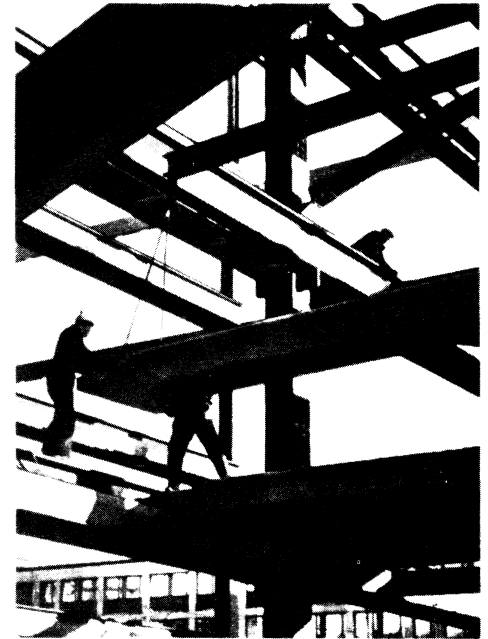
Установка сборных предварительно напряженных железобетонных плит
