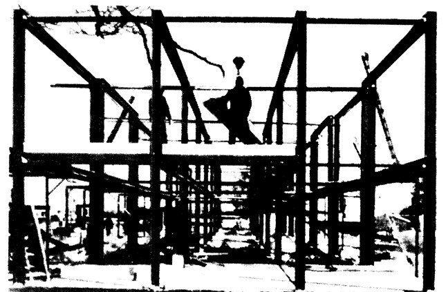
Стальной каркас со смещенными в плане продольными рамами
