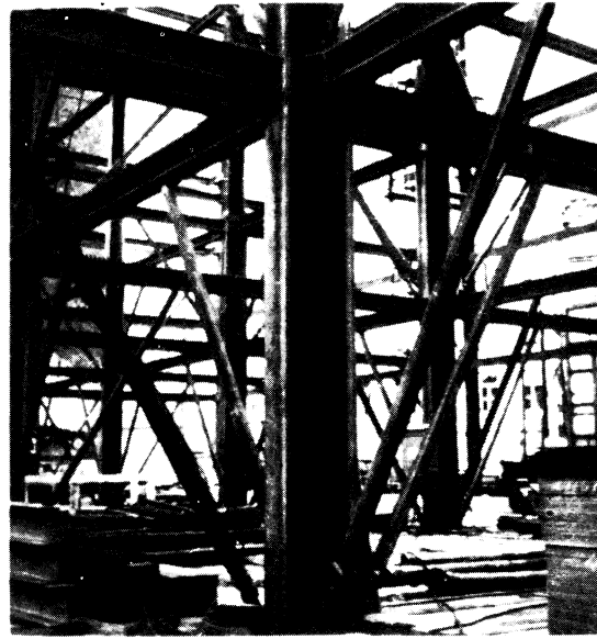
Предварительное напряжение балок перекрытия около внутренней колонны
