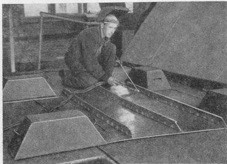
Рис. 36. Установка набора с помощью электроприхваток.
