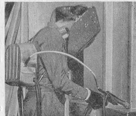
Рис. 63. Сварка выгородок на стапеле полуавтоматом ПРМ-4.
